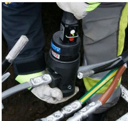
Dorn-Crimpen eines Elpress-Stoßverbinders mit Crimpkopf V250.
