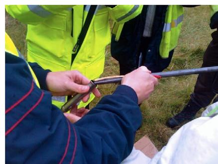
3. Der Erdungsleiter wird an der gehärteten Stahlspitze des Führungsrohrs befestigt.
